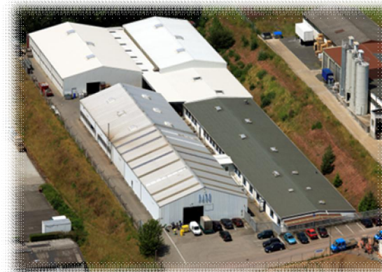
Werk III Steinau - Gewebelager - Filterbau
